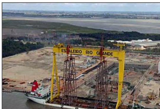
Estaleiro Rio Grande – RS
